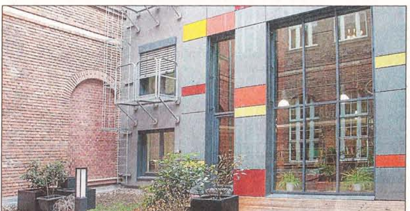
Neu trifft auf Alt: Der Bibliotheksanbau mit seiner glatten Fassade, auf der sich der alte Trakt widerspiegelt.
